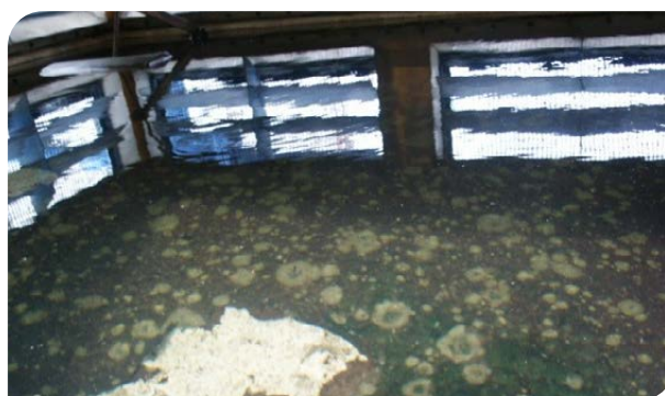
Rys. 4.3. Glony w wentylatorowej chłodni wieżowej
