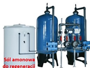
Rys. 5.1. Graficzne przedstawienie klasycznej metody zmiękczania wody dla układów chłodzenia [14]
